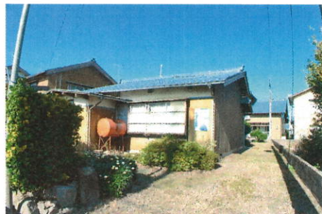
現地外観写真 現地(2023年10月)撮影
